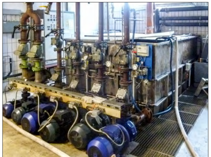
Pumpenanlage Rückkühlsystem
